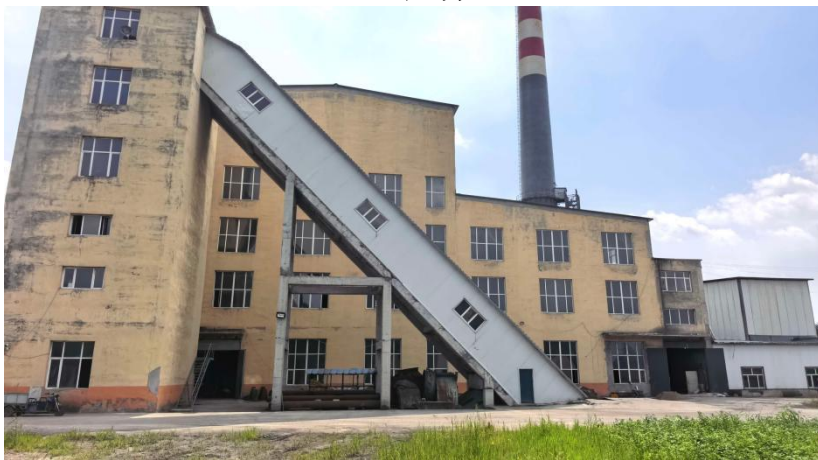
封闭式输煤栈桥、输煤楼
