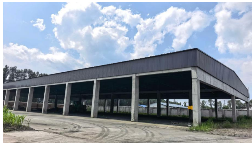
半封闭煤库、灰渣库
