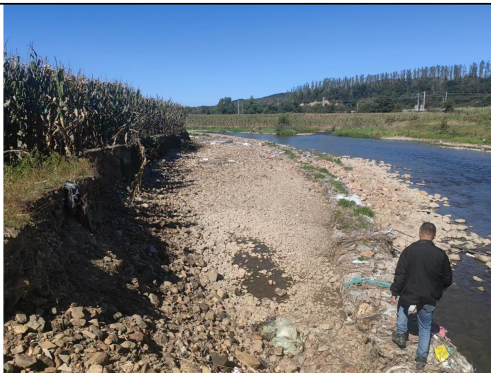
图 2-10 护岸 4 仅剩固脚退岸严重
