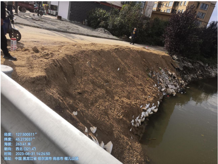
图 2-1 左岸 1-1 现状无护砌
