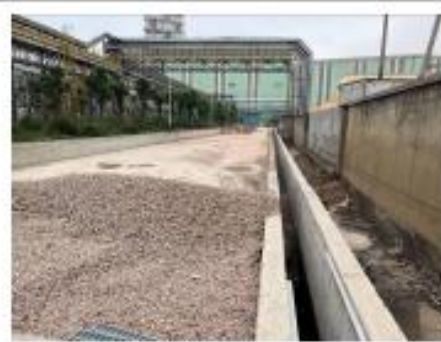
变电站南侧厂界外环境
