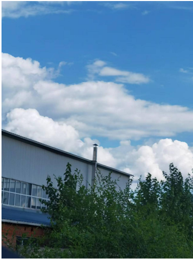
车间 15m 高排气筒
